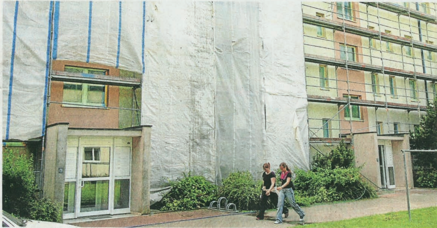
Ein Miethaus wird saniert: Die Eigentümer fordern mehr politische Unterstützung, weil sich Investitionen sonst oft nicht lohnten.
